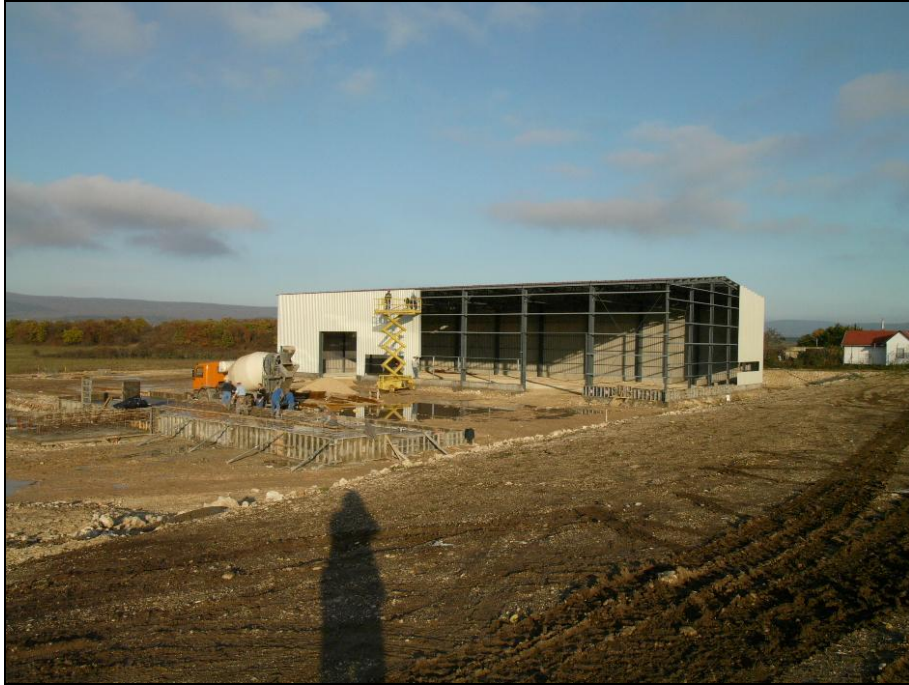
Tapolca, válogatócsarnok és az átrakó állomás alapozási munkái – 2009. november 9.
